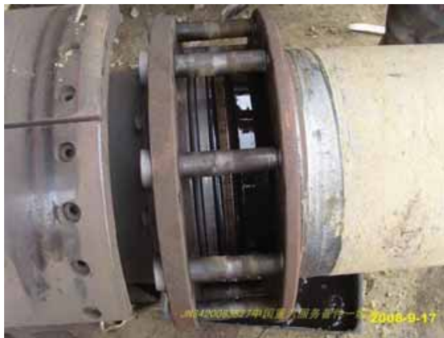
Рис. 2-3 Ремонт уплотнительного кольца
