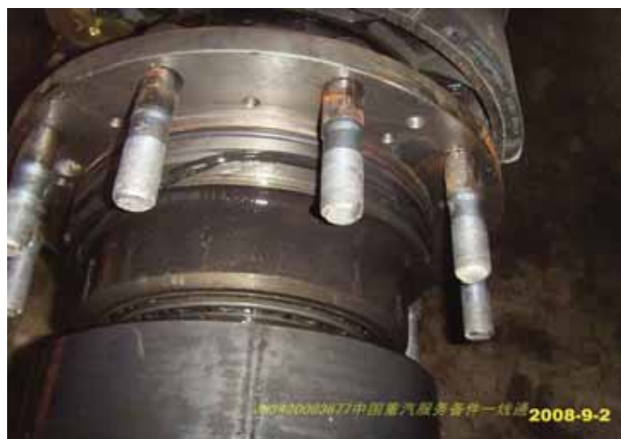
Рис. 2-4 Ремонт уплотнительного кольца
